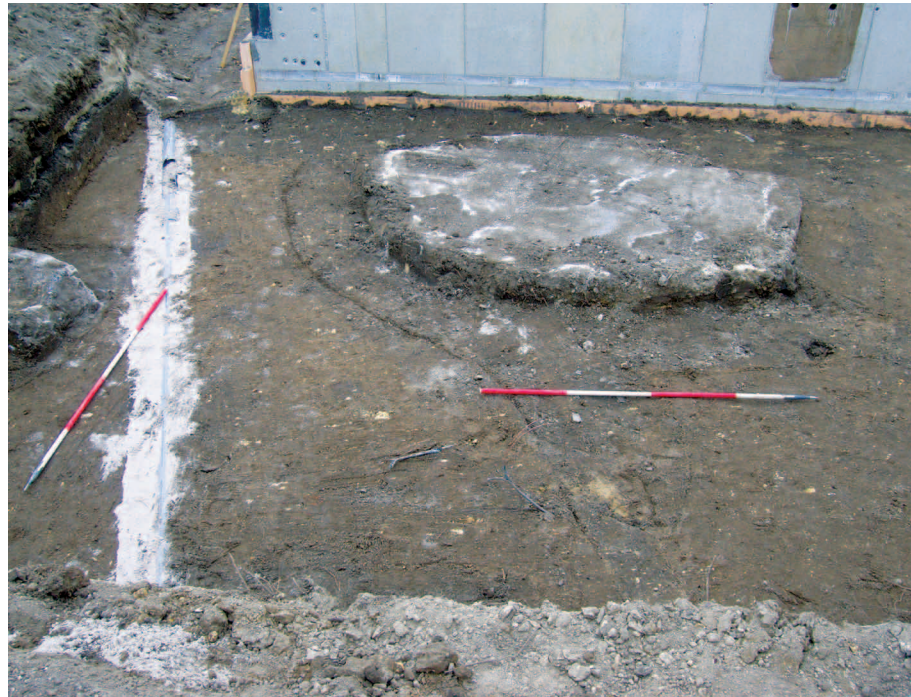
Afbeelding 3.25 De bezinkput en de betonnen bak die ernaast lag.
