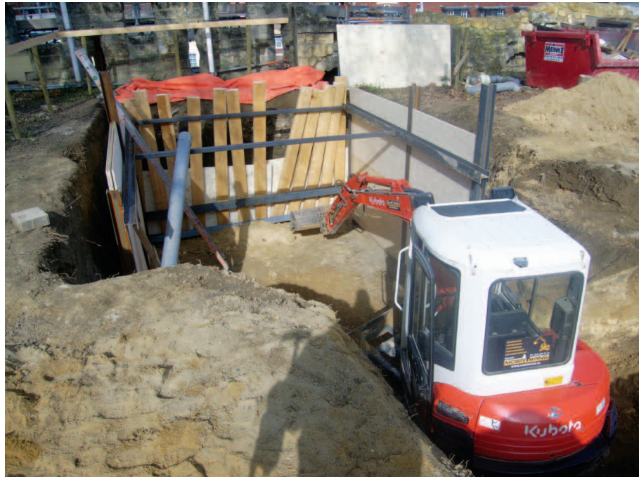
Afbeelding 2.11 Bekisting in de liftschacht met de kraan in het talud.
